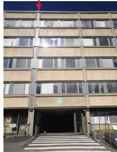
Julkisivuelementtien poikkeava etäisyys kielii rakentamisen vaiheistuksesta (punainen nuoli).
